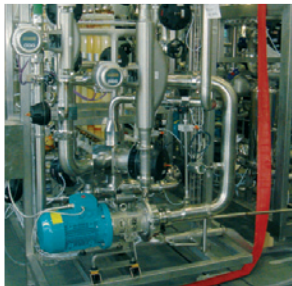
Gummi-Metall-Elemente reduzieren Vibrationen
