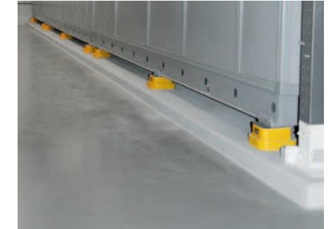
Schwingungen werden direkt an ihrer Entstehungsquelle durch APSOvib® Schwingungsdämpfer abgefedert.
