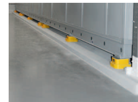
Les vibrations sont amorties directement à leur source grâce à l'intervention des systèmes antivibratoires APSOvib®.
