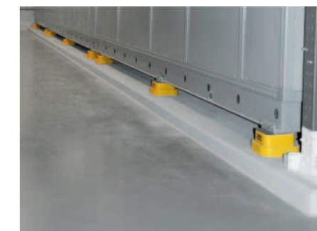
Trillingen worden direct bij hun ontstaansbron verend opgevangen door APSOVib® trillingdempers.
