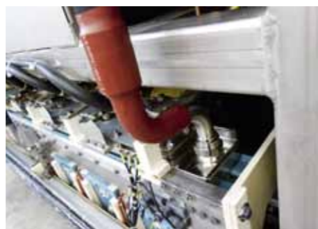
Flexibles de connexion spécifiques doublement recourbés (90°) avec manchons rétractables pour une meilleure isolation électrique
