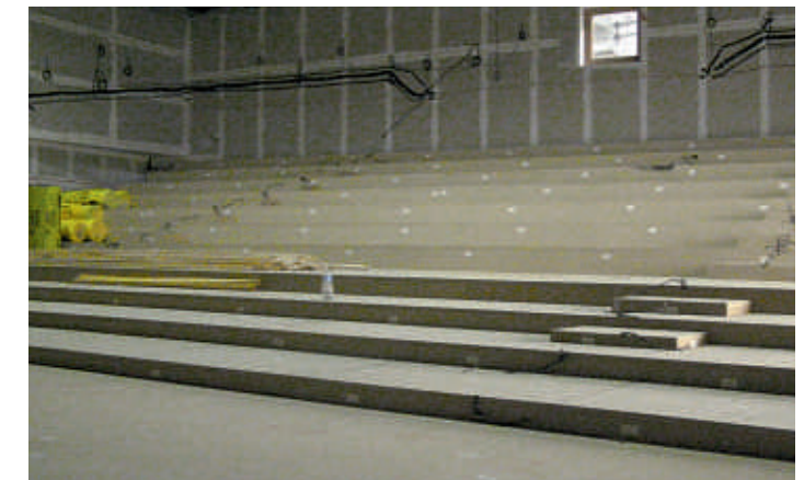
Unterschiedlich dicke Polyurethanschaum-Puffer absorbieren Schall und Vibration.
